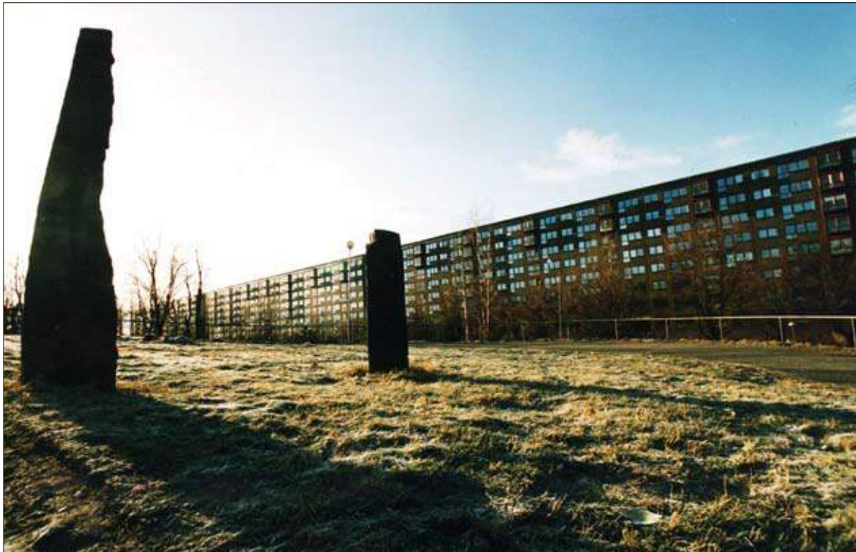
Östra Gårdsten före ombyggnaden. Huset sträckte sig närmare en kilometer från gavel till gavel.
