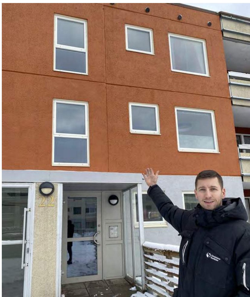
Fasadrenovering i västra Gårdsten.
